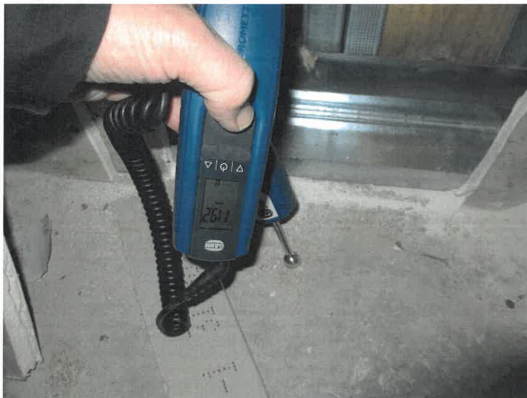
Foto 1.3 – 2.4. Åbning U01. Fugtmåling i betondæk ud for udsparring.
