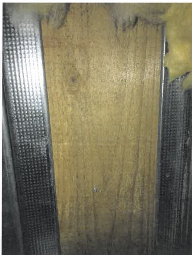
Foto 1.3 – 2.2. Åbning U01. Krydsfiner mod udsparing for tagnedløb.
