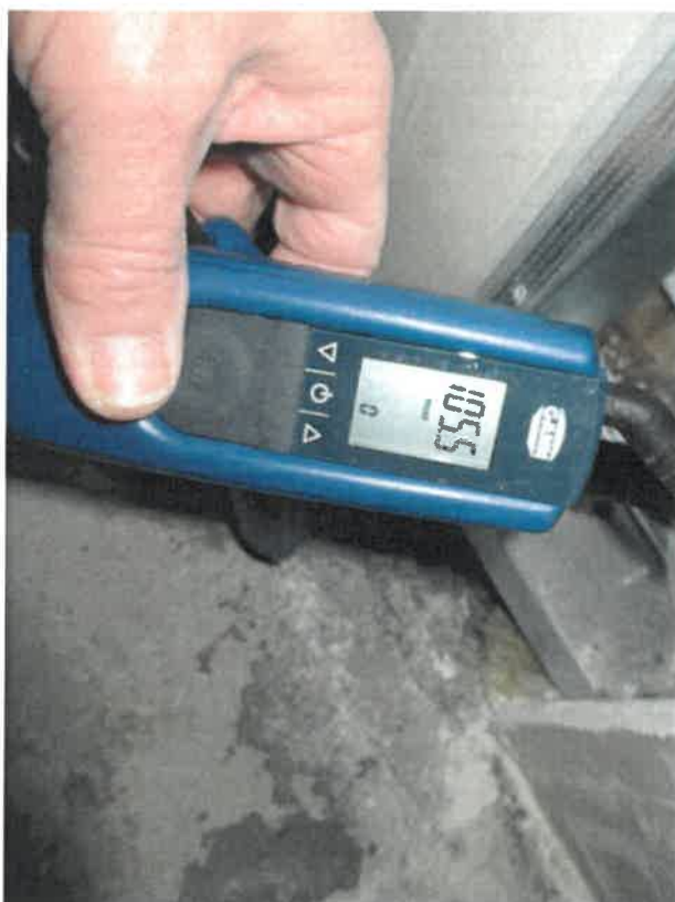
Foto 1.3 – 2.12. Åbning U02. Fugtmåling i betondæk ud for udsparing.
