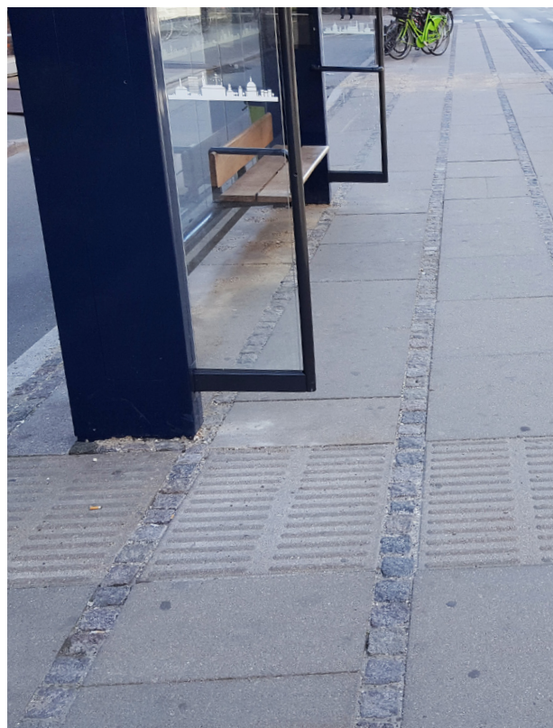
Buslæskærm med retningsfelt ved standeren, der angiver for blinde og svagtseende hvor busdøren er.
