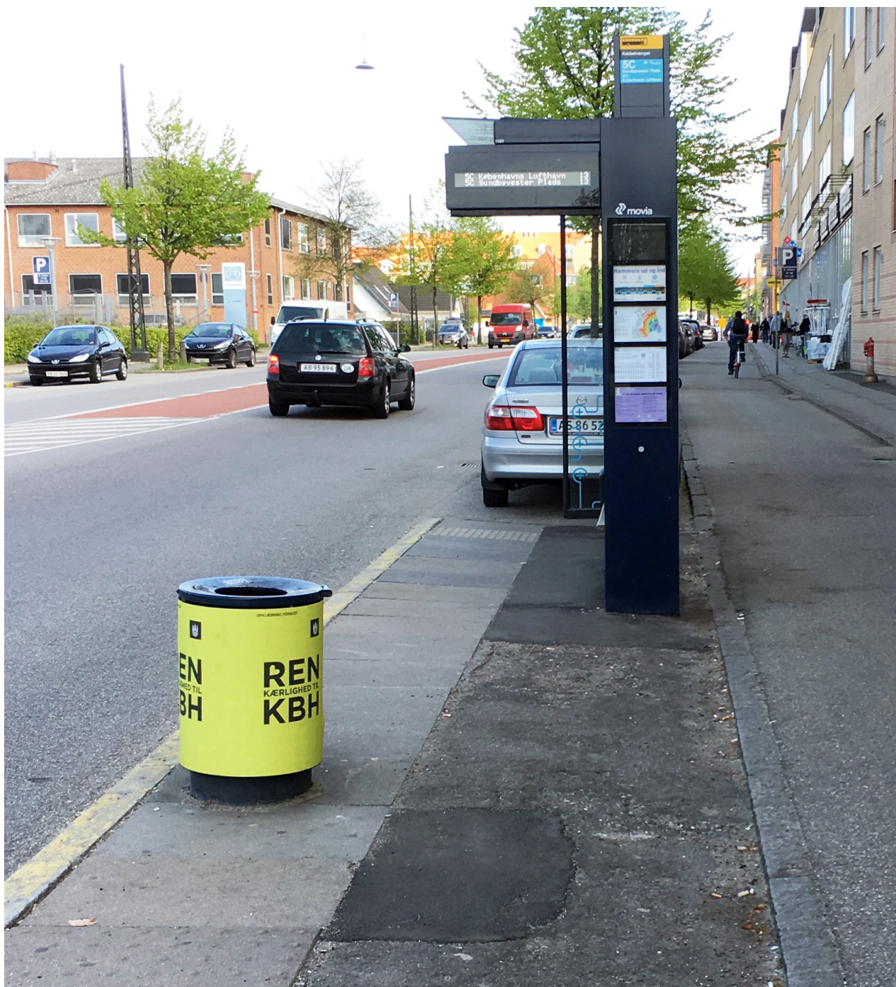
Foto af busstop på Husum Park Ruten. Busperronen er for smal, har ujævn belægning og mangler retningsfelt ved stoppestedsstanderen.
