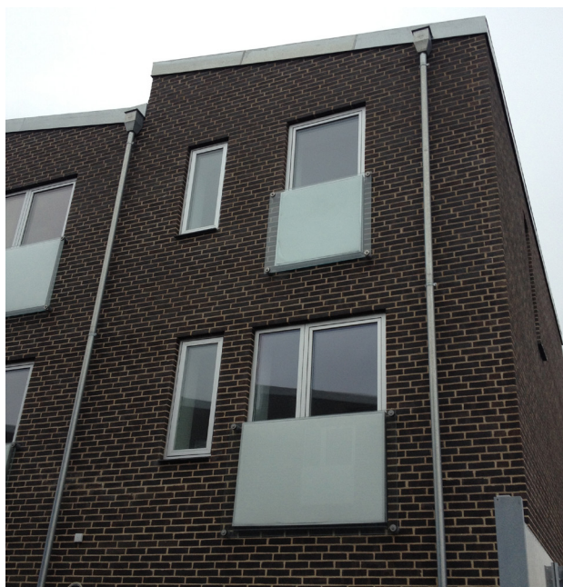
Figur 1: Glasafskærmning foran opdelt fransk altandør med indbygget absorber.
