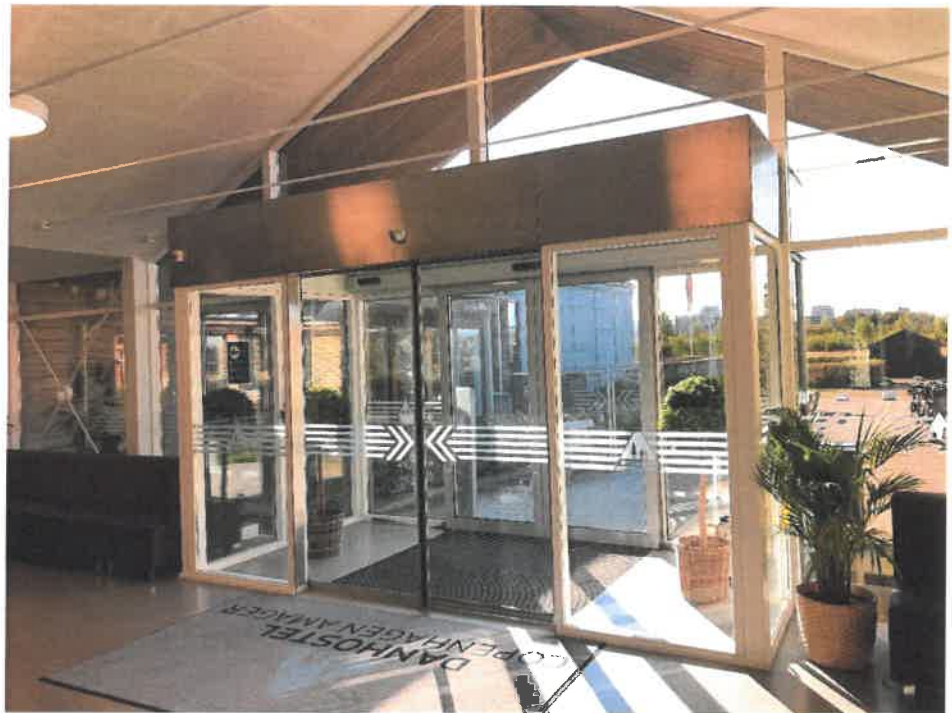
Indgangsområdet med glaspartier, designgulv og akustikplader.
