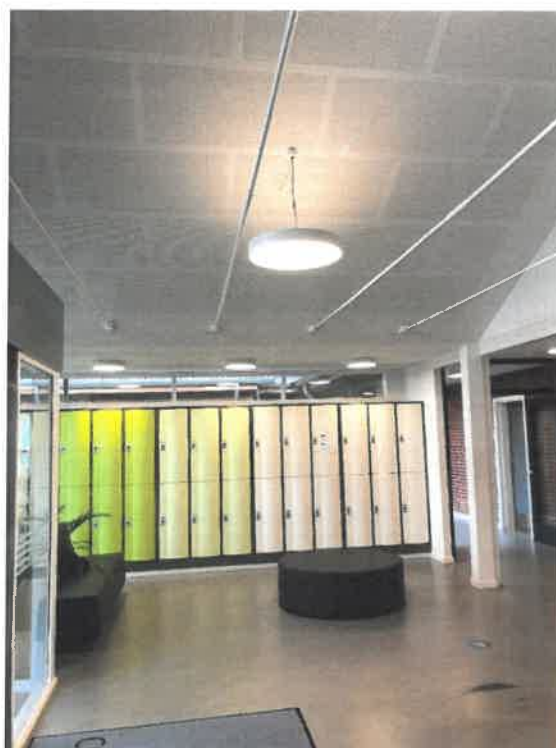
Indgangspartiet set fra øst/receptionen. Underlofter er akustik-plader og gulvet er et nyere designgulv. Der er ikke udtaget materialeprøve af designgulvet.
