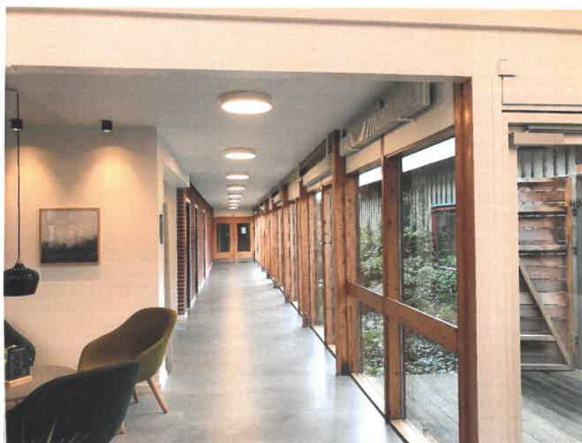
Gangareal øst for receptionen. akustikplader i underloft og lakeret træværk. Træværk og vinduer er originale fra Danhostels opførelse.
