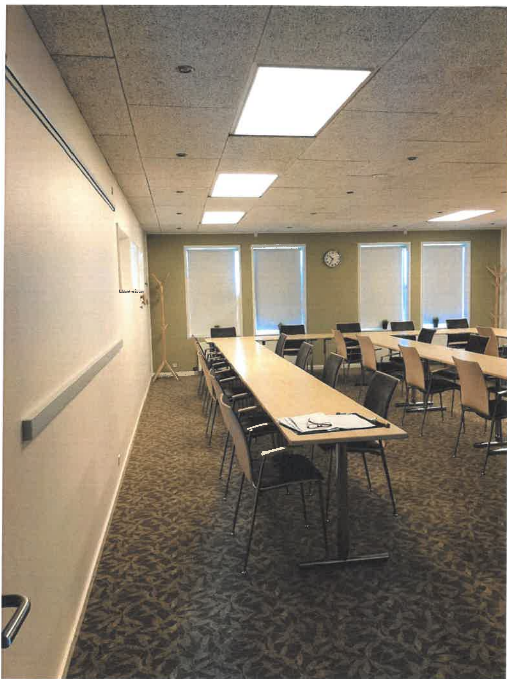
Mødelokale med gulvtæppe og Trolldtekt underloft.
