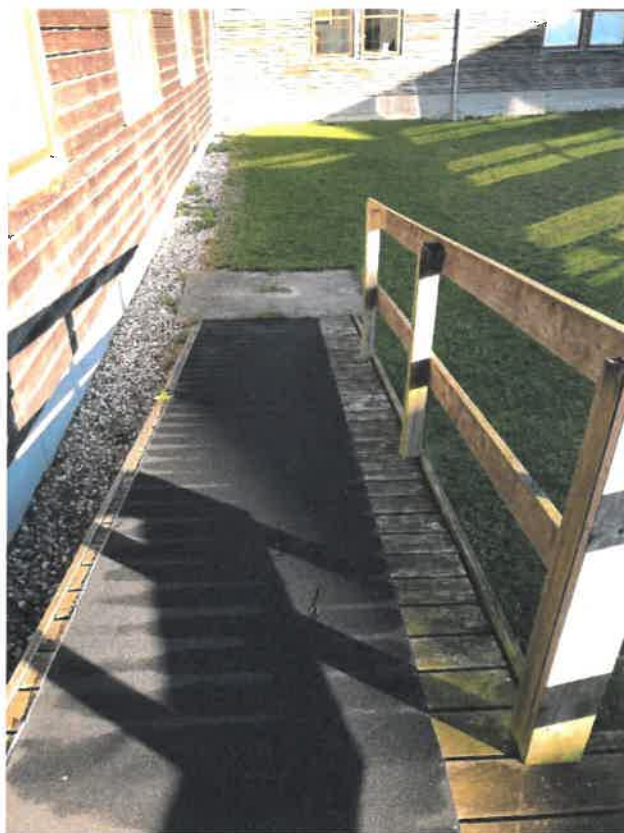
Rampe i træ – der er en tagpap-lignende belægning på rampen.
