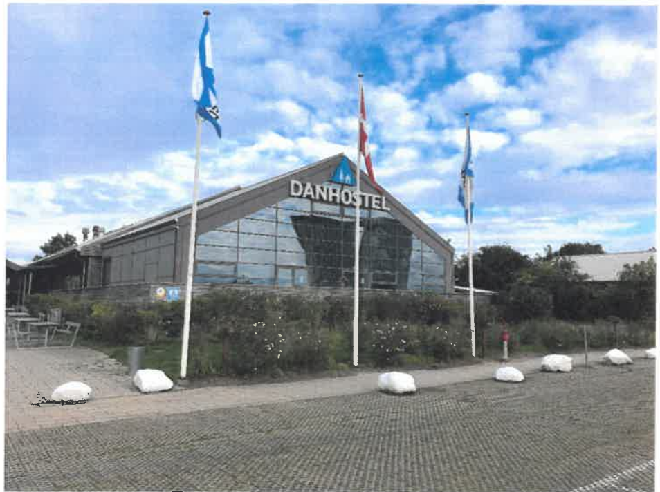
Danhostel set fra syd. Bygningdelen med glasfacaden er den nyeste del af kantinen, som er opført 1996-1998.
