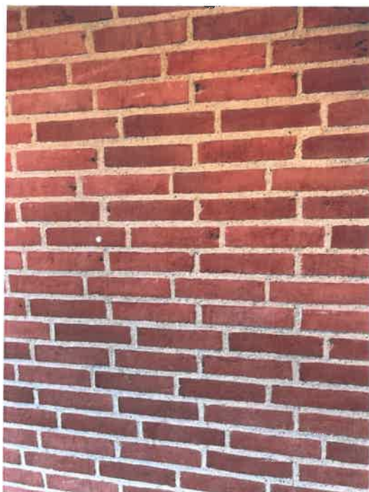
Original murstensvæg i gang mellem fløj AB og CD. Der er ikke udtaget materialeprøver af mursten eller fuger.
