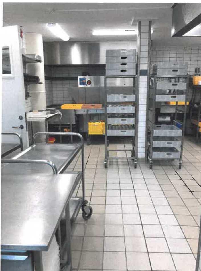
Nyere køkken (1996-1998, sydlige del) med hvide og beige gulvfliser og hvide vægfliser.
