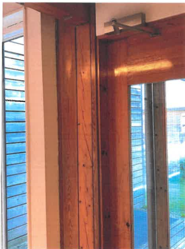
Lakeret træværk i mellemkorridor.
