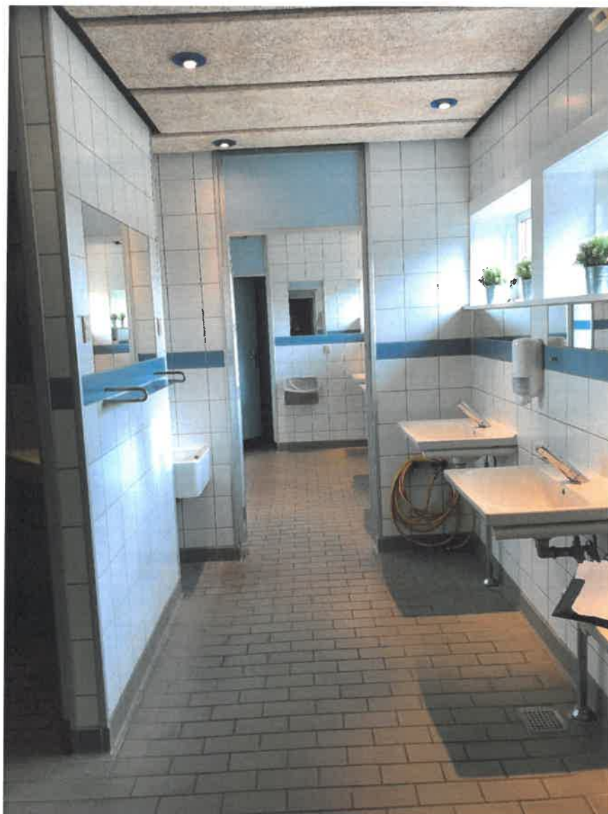
Fællestoilet gang EF. Der er ikke udtaget materialeprøver af væg-/gulvbeklædning.
