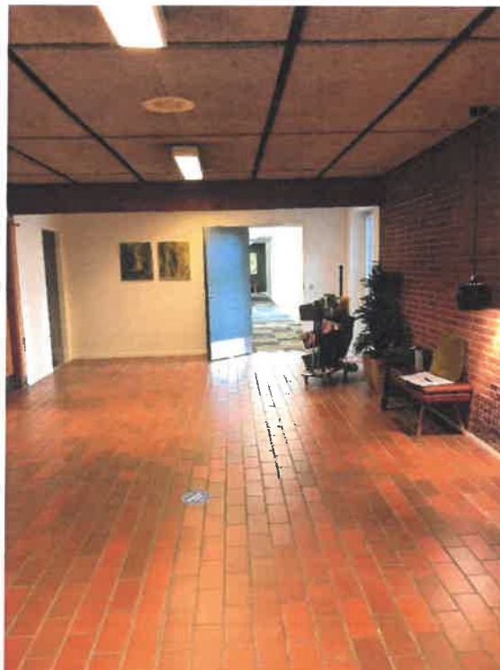
Mellemkorridor mellem Fløj C og D med originale røde gulvfliser, murstensvæg og troldekt-underlofter på sortmalet træ.
