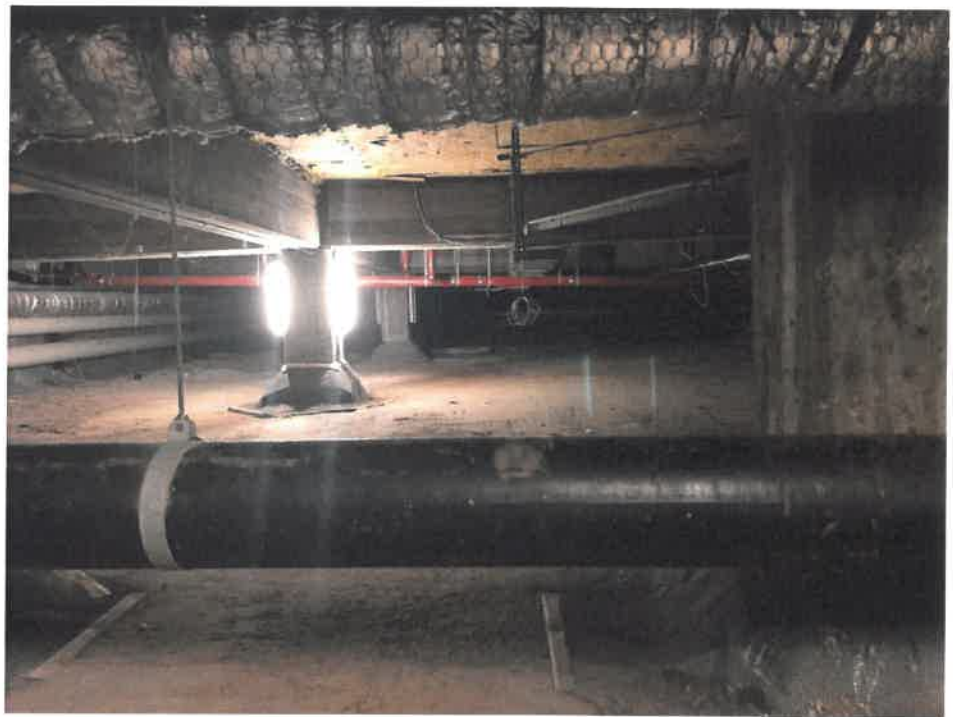
Ingeniørgang – nedgang fra fyr-/teknikrum. Isolering i loft er ophængt med klammer.
