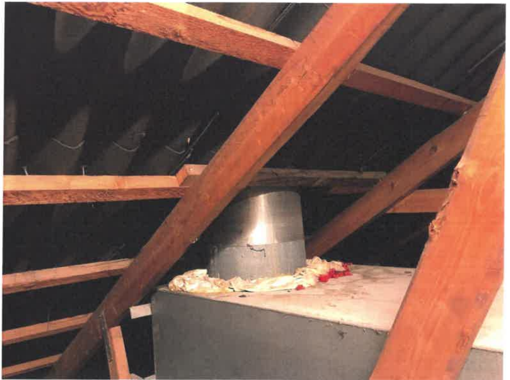
Loft med spær og underloft i blødt materiale.
