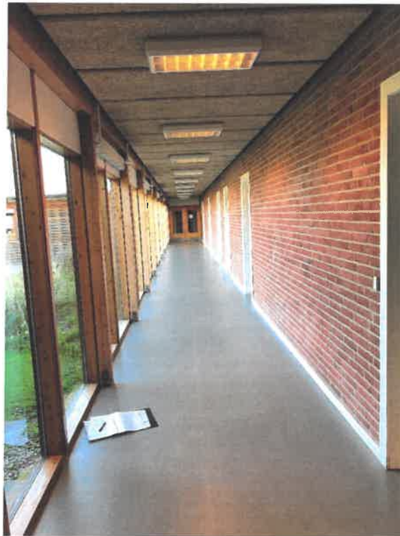
Gang mellem Fløj AB og CD med designgulv og troldekt-underlofter på sortmalet træ. Original murstensvæg til højre og originale vinduespartier til venstre.
