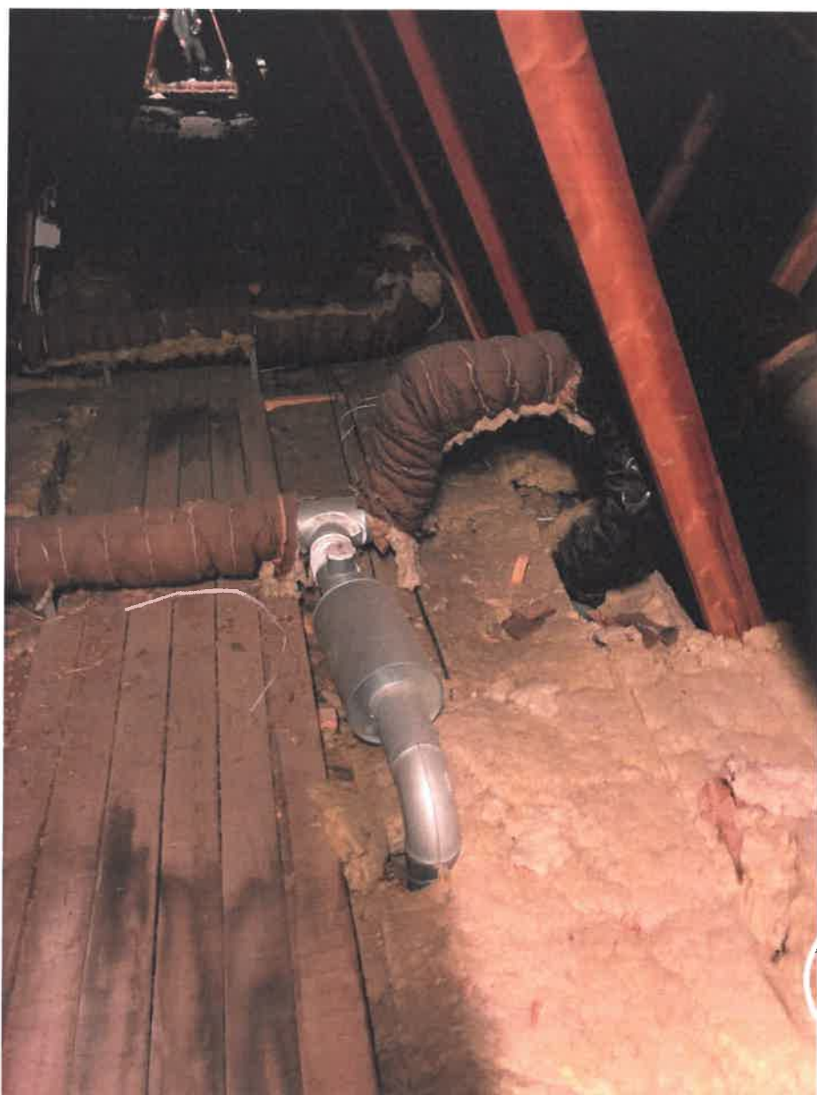
Loft over fællestoilet – gangbro i træ, spær, isolering udlagt på loft og isolerede rør.
