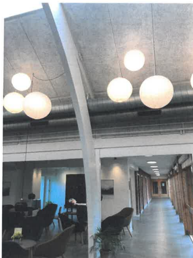
Opholdsareal øst for receptionen. Trolldtekt underloft og designgulv. Træværket er lakeret. – det er det bemalede træværk, der er tydeligst, så måske skal det angives hvor på billedet det lakerede træværk kan ses ...
