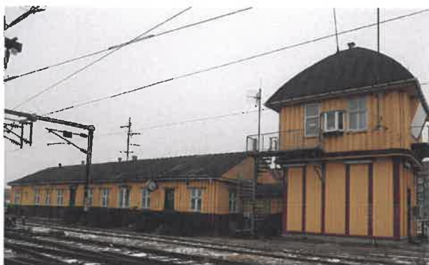
På baneterrænet nord for Den Gule By ses denne bygning, der rummer arkitektoniske og kulturhistoriske kvaliteter.
