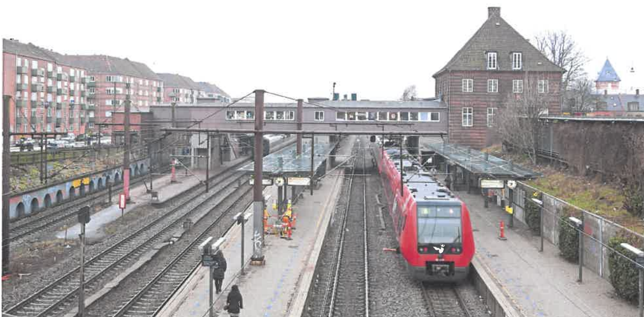
Valby Station er om- og tilbygget flere gange, bl.a. med gangbroen over banearealet fra begyndelsen af 1950'erne.
