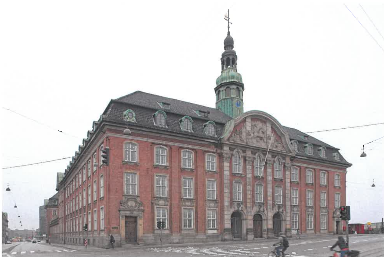
Centralposthuset på hjørnet af Bernstorffsgade og Tietgensgade udgør kulturmiljøafgrænsningen mod vest.
