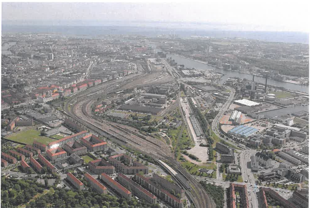
Området set mod øst. Centralværkstedets-området ligger som en velafgrænset helhed, der er omgivet af skinner på alle sider. Det tætte Vesterbro ses til venstre, Fisketorvet og H.C. Ørstedværket til højre og Bavneshøjkvarteret i forgrunden. (JW Luftfoto juni 2006).
