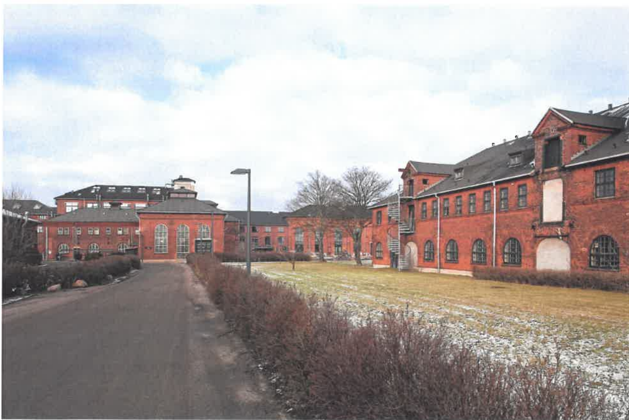
Centralværkstedets karakteristiske værkstedsbygninger og bygninger er relateret til jernbanefunktioner. Stilen er historicistisk, og kulturmiljøets mange bygninger, torve, pladser og grønne friarealer rummer mange arkitektoniske og landskabelige kvaliteter.
