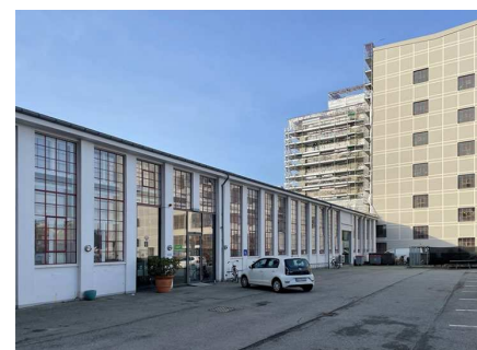
5. Monteringsshal fra 1930, der udpeges som bevaringsværdig.
