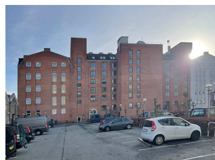
4. Fabriksbygninger opført mellem 1921-1942, der udpeges som bevaringsværdig.
