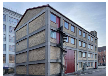
8. Kortslutnings-prøvestation fra 1959, der udpeges som bevaringsværdig.
