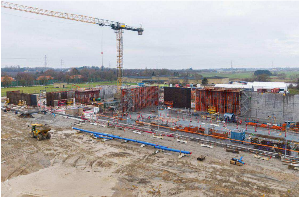
Figur 2. Foto af in-situ støbning af de nye store rentvandsbeholdere i beton.
