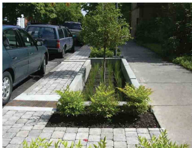
Regnvandsopsamling i bed i urban udformning
