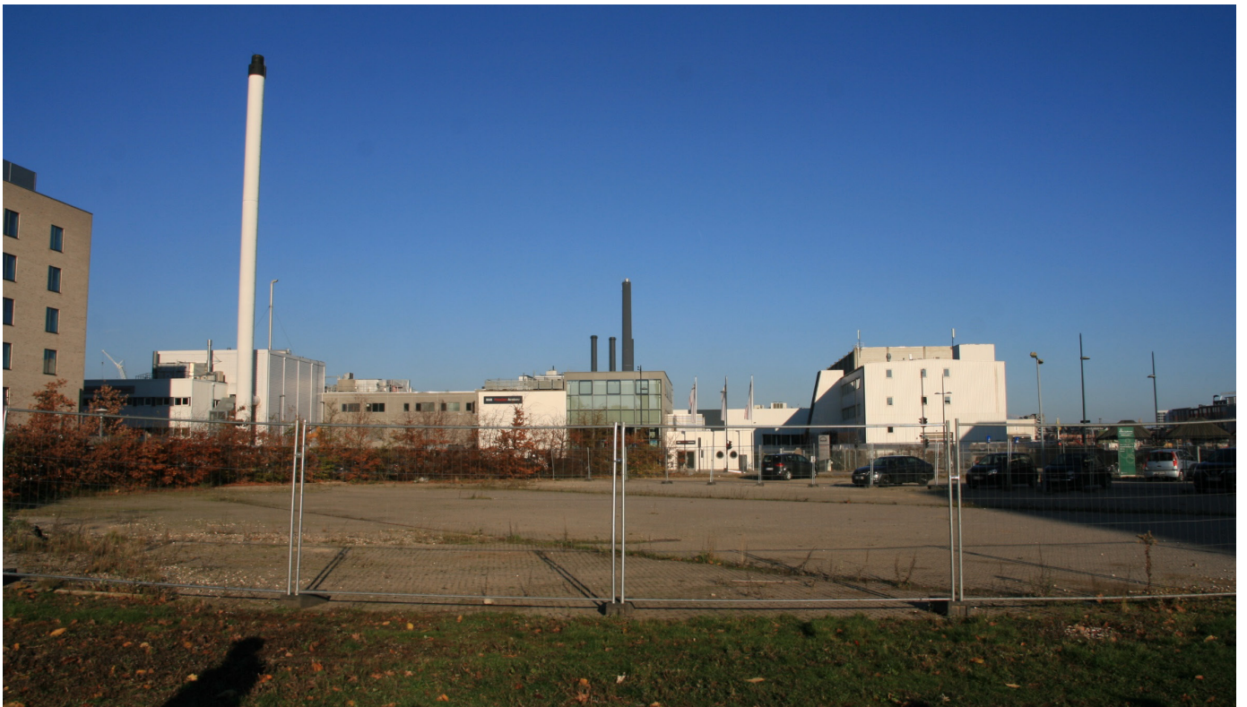
Byggegrunden set mod virksomheden MAN Energy Solutions, umiddelbart nord for Teglholsgade.
