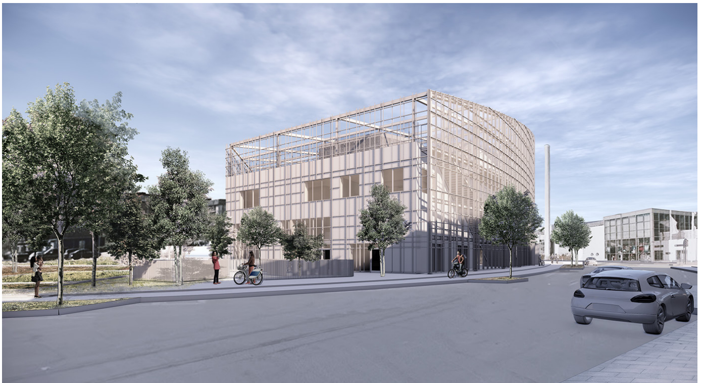
Visualisering, der viser et eksempel på et nybyggeri i overensstemmelse med lokalplantillægget. Her ses nybyggeriet med den omkransende konstruktion til støjskærm fra syd. På facader mod forpladsen og den grønne kile er der ikke behov for at støjskærm for virksomhedsstøj, og her er ikke monteret glas i konstruktionen, som mod Støberigade og facader mod nordvest og vest. På selve forpladsen er lav indhegning til renovation med træer omkring. Hvis muligt i forhold til ledninger plantes op til fire gadetræer ud for grunden. Illustration: TRUST.
