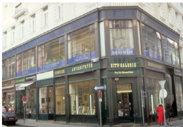
Eksempel på facade, hvor 'basen' har fået et markant andet udtryk end etagerne ovenover.
