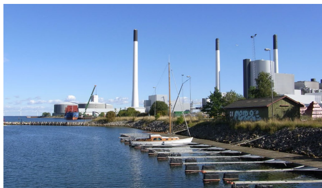
Amagerværket set mod nordøst
