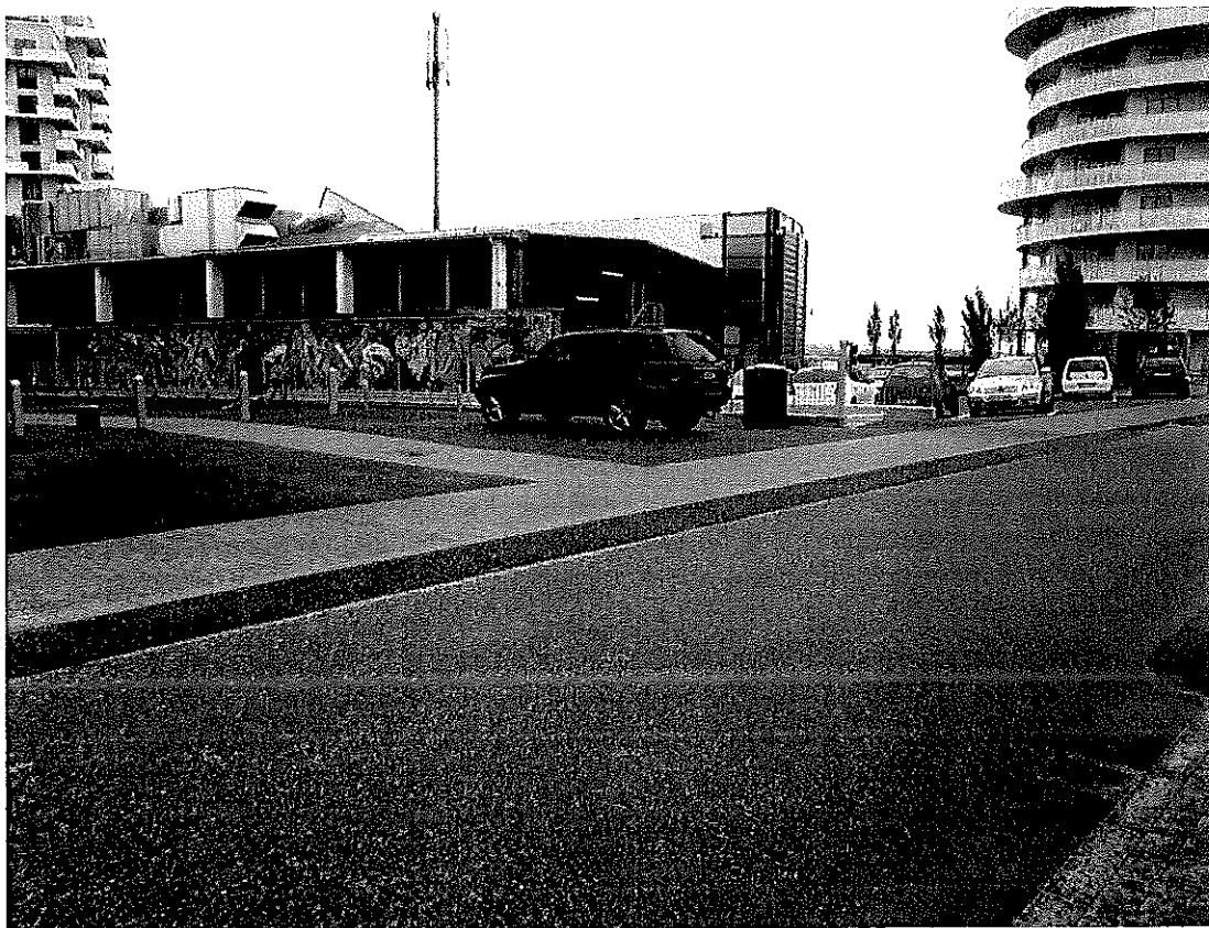
Kik fra vores hus, hvor der skulle have været en grøn kile mellem byggerierne.
