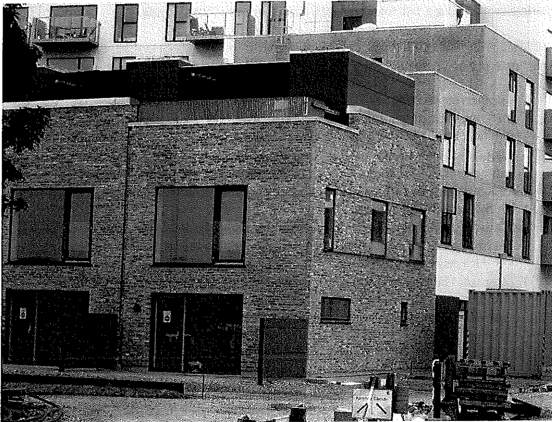
Nye rækkehuse på Krimsvej
