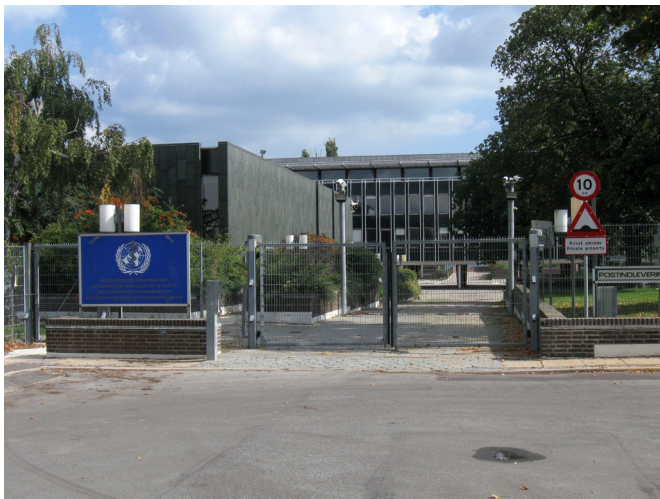
Indkørsel til den eksisterende erhvervsbebyggelse på Scherfigsvej 8. Ejendommen er omkranset af et højt gitterhegn med automatiske porte og fremstår meget lukket.
