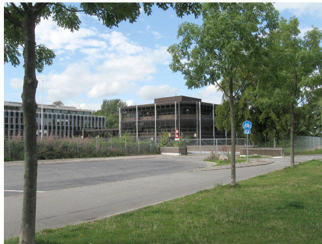
Indkørsel til ejendommen fra Strandpromenaden. Også fra denne side fremstår ejendommen meget lukket.
