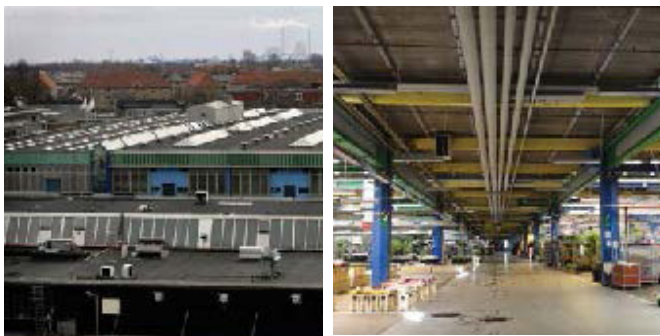
Grønttorvshallen udefra (tv.) og den indvendige konstruktion, der bevares delvist. Fotos: Polyform.
