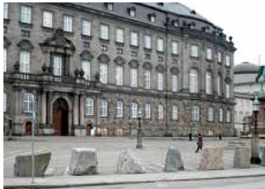
Midlertidig sikring med ca. 110 cm høje granitsten
