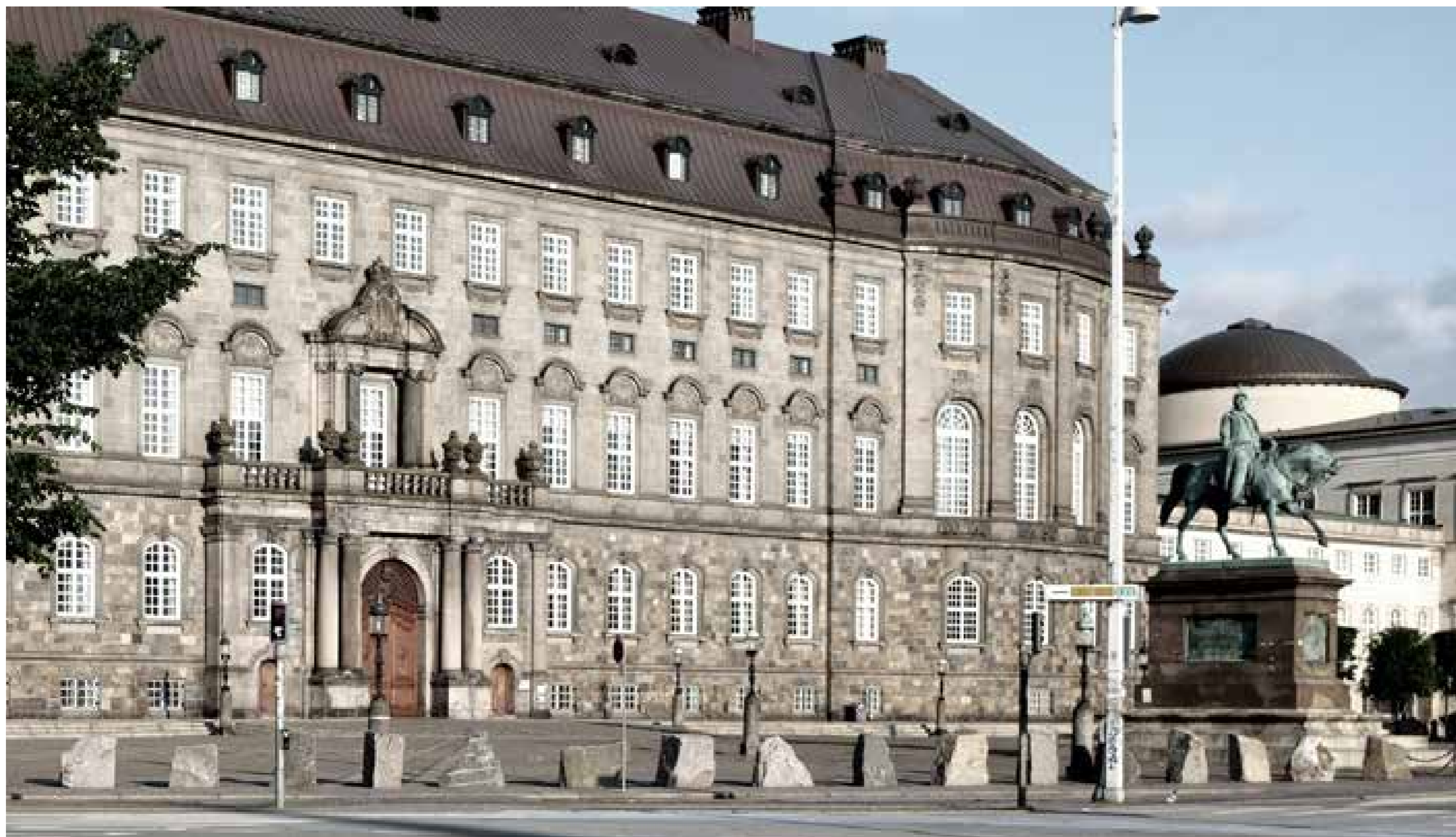
Slotspladsen med den nuværende midlertidig områdesikring
