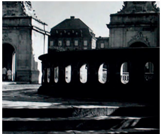
Langs Slotspromenaden og ved Marmorbroen kan belæggingerne lang kaj kanten stå strammere med forløb af borduresten og chaussésten i enkle gennemgående stræk
