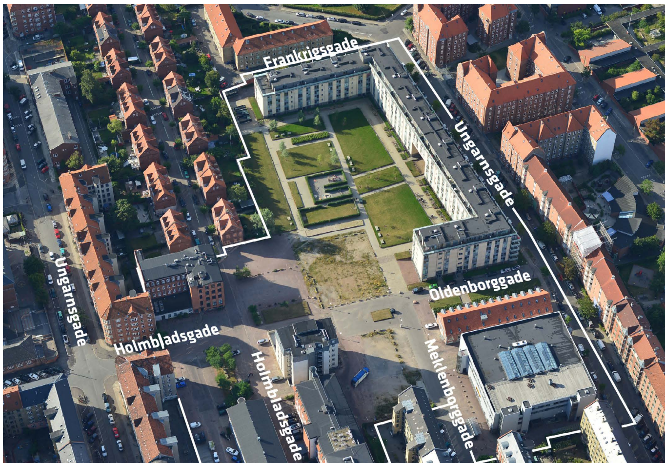
Luftfoto af lokalplanområdets indre set mod syd
