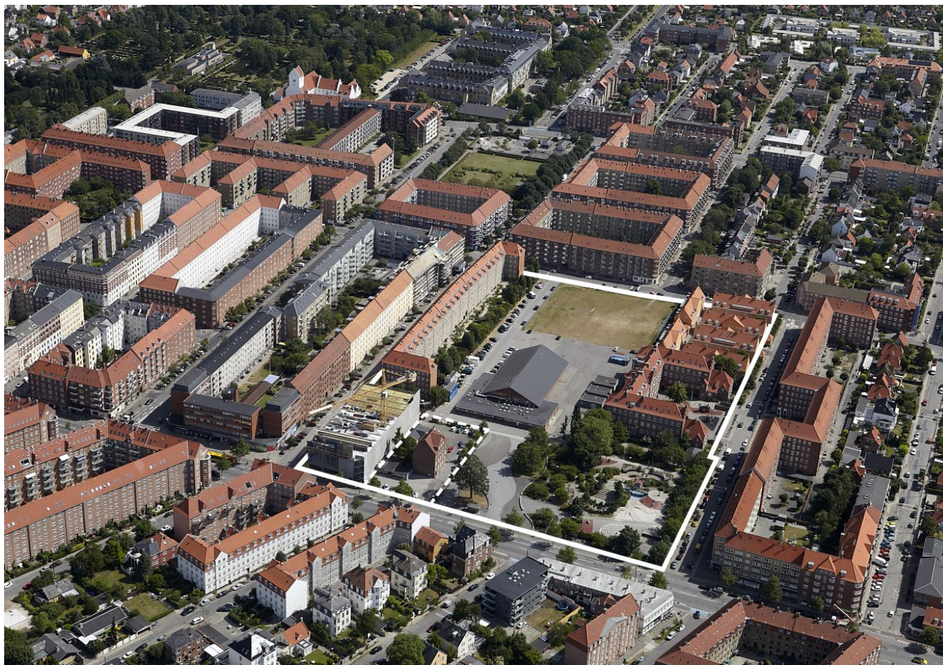
Luftfoto, juni 2014. JW Luftfoto
