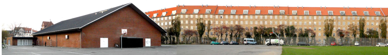
Billedet viser arealet bag ved Sundbyøsterhallen og det grønne idrætsområde. I baggrunden ses randbebyggelsen mod Parmagade.
