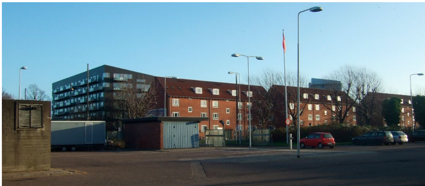
Nabobebyggelse på den modsatte side af Hulgårdsvej, nr. 130-146, med Hulgårds Have i baggrunden, set fra lokalplanområdet
