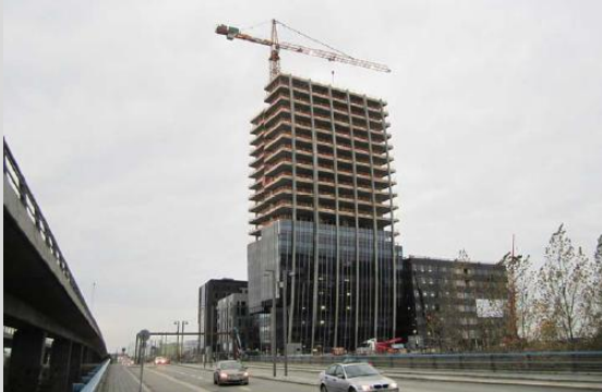
Nuværende erhvervsbyggeri – Copenhagen Towers 2
