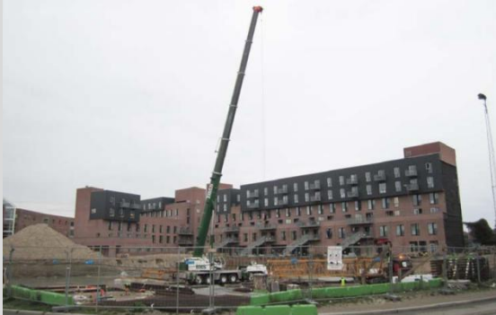
Kontorejendom og byggeri ved Ny Ellebjerg St.
