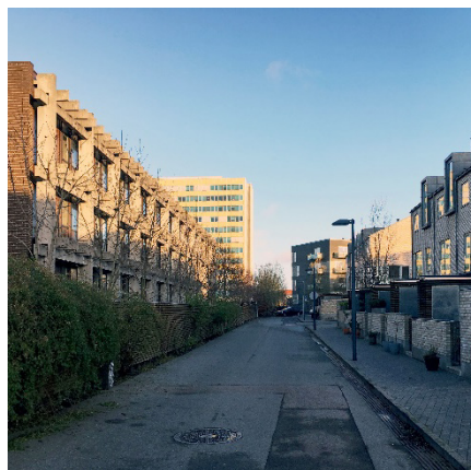
Overgang mellem det nye og det gamle F.L. Smidth i områdets sydlige del. Til højre rækkehusebebyggelse i 'Valby Have'. I baggrunden ses kontorbygningen i 12 etager.
