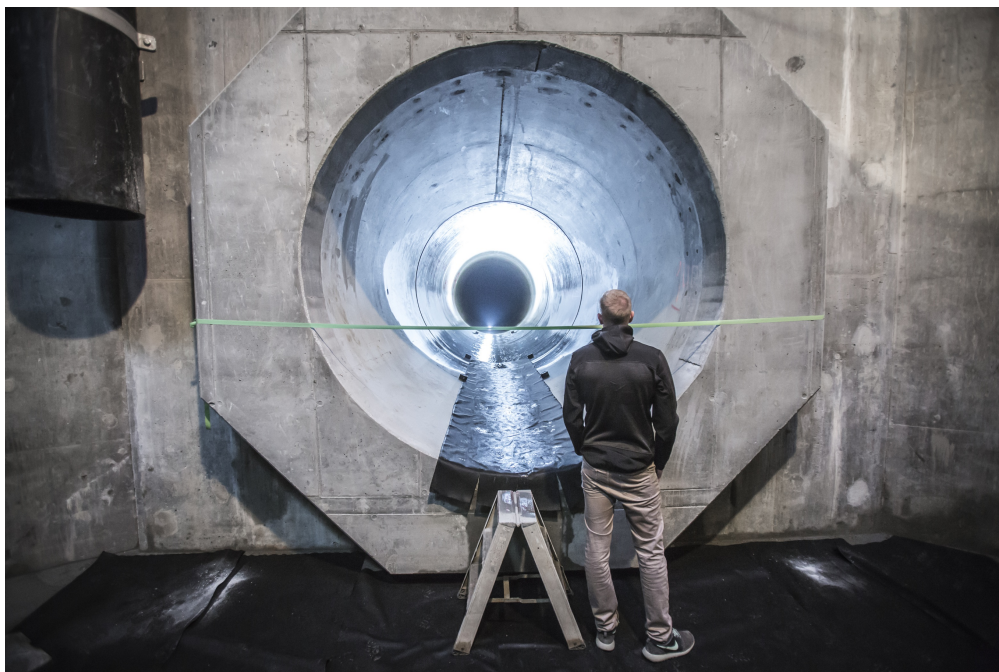
Østerbro skybrudstunnel. Foto: HOFOR
