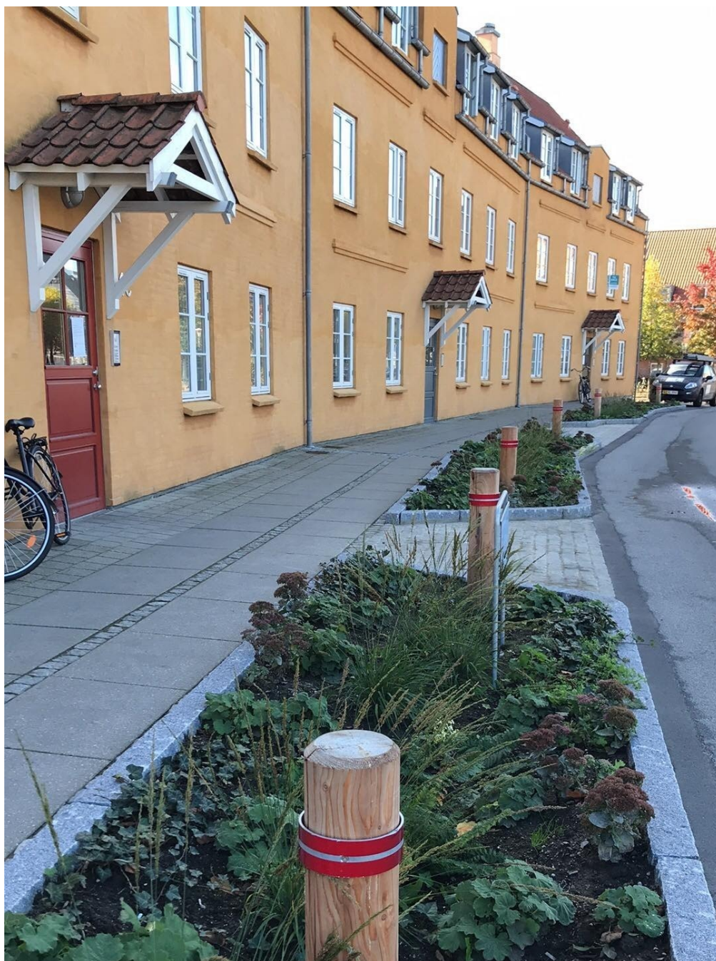
Vejbed til forsinkelse og nedsivning af regnvand på Erik Ballings Vej. Foto: Louise Madsen
