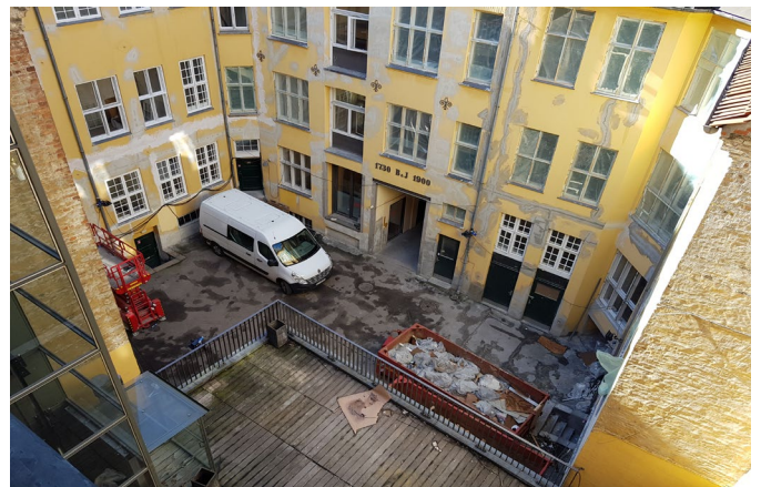
Selve gårdrummet i lokalplanområdet er lille. Der er en tagterrasse i 1. sals højde på Nørregade 15.
