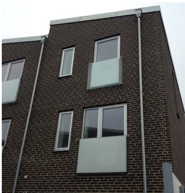
Figur 1: Glasafskærmning foran opdelt fransk altandør med indbygget absorberent.
