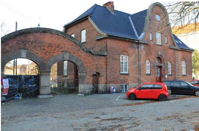
Bygning fra 1913 på hjørnet af Valgårdsvej og Vigerslev Allé med tilhørende portal, der stammer fra Sadolins Farvefabrik. I dag rummer den spillestedet Kraftverket. Bygning og portal fastlægges som bevaringsværdig.
