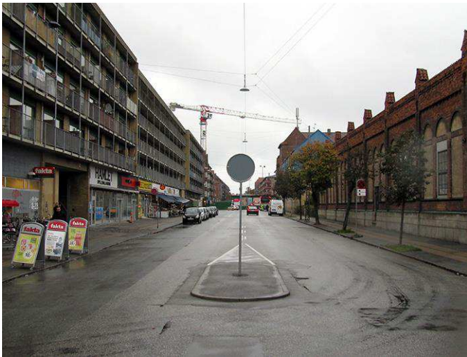
Hamletsgade set mod Tagensvej og Skjolds Plads Metrostation.
