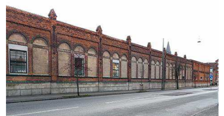
Hamletsgade 9 - Spinderibygning I.
