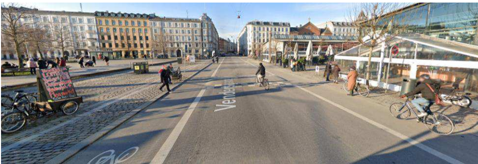
Figur 7 – Førbillede på strækningen foran Torvehallerne, hvor der er cykelbaner på begge sider af vejen. Der er etableret bump som hastighedsdæmpende tiltag.
