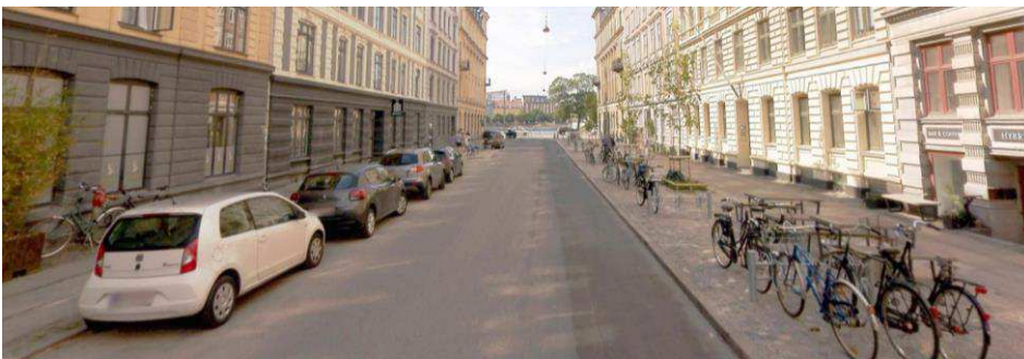
Figur 6 – Efterbillede på strækningen mellem Søtorvet og Nansensgade, hvor vejen er ensrettet i retning mod vest. På den sydlige side af vejen er der parkering i afmærkede p-baner (billedet er taget ind afmærkningen blev etableret) og på den nordlige side af vejen er der etableret et bredere fortov med plads til træer og cykelparkering.
