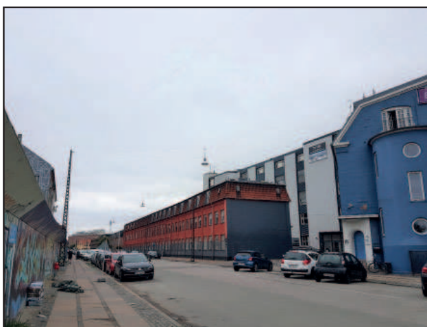
Eksisterende boligbebyggelse set fra Aldersrogade
