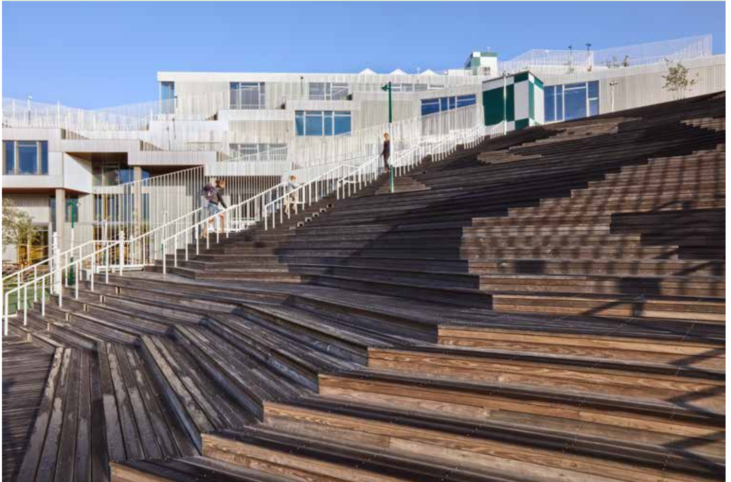
Terrasse af varmebehandlet træ, Skole i Sydhavnen (foto af Jonas Lodahl)
