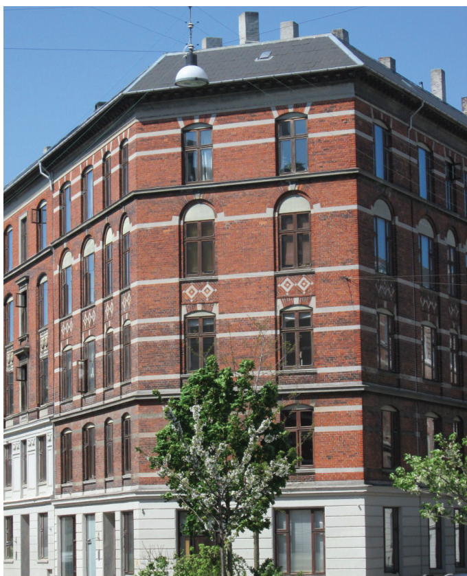
Facade mod Dybbølsgade
