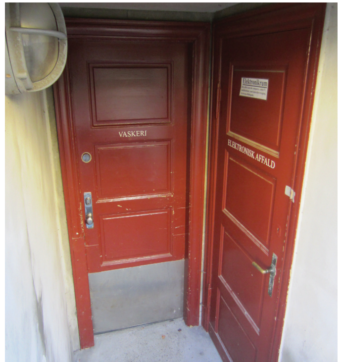
Kælderdøre sikres mod skybrud
