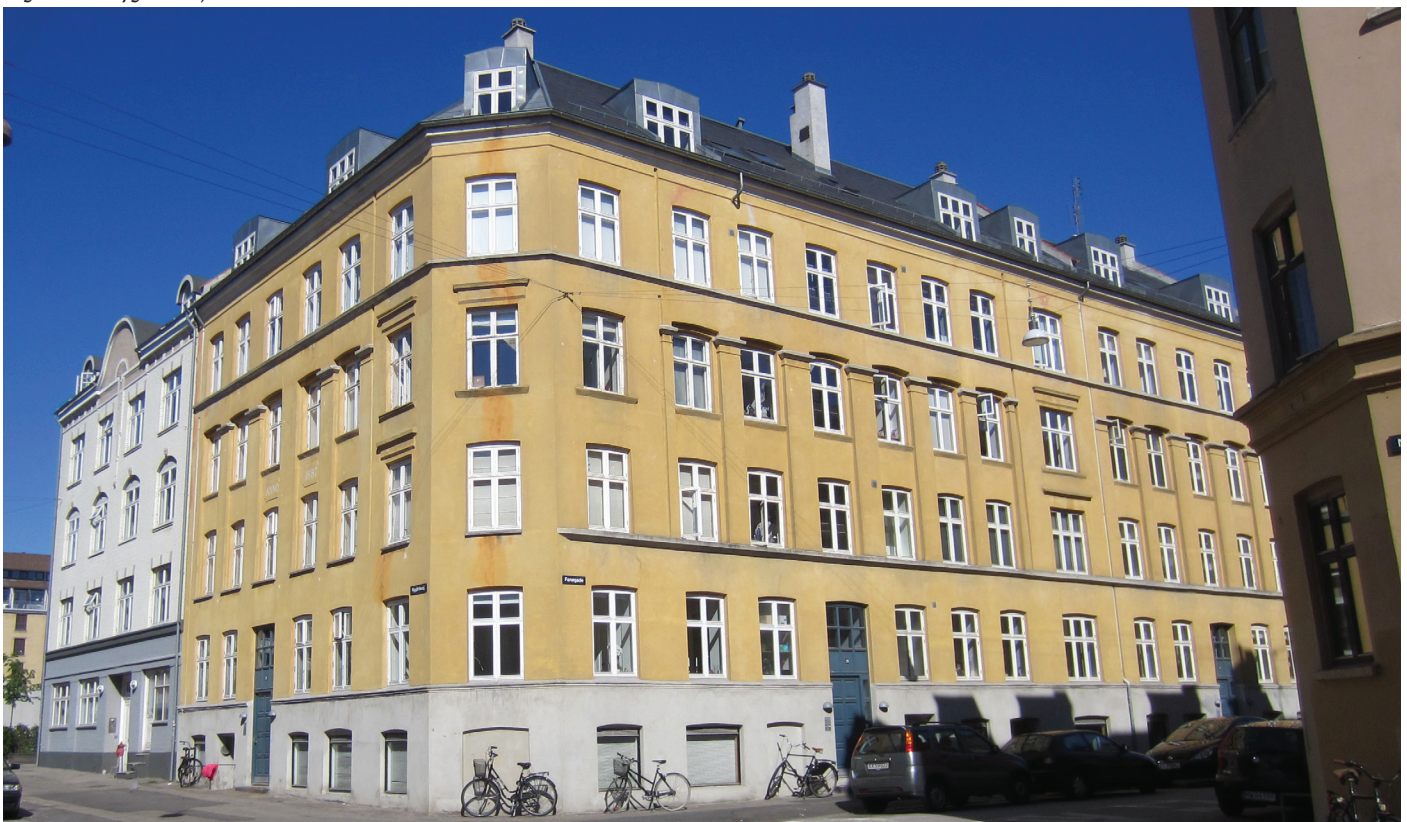
Facader mode Nygårdsvej og Fanøgade
