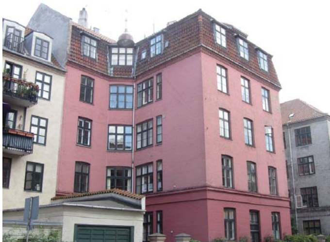
Facade mod Thorupsgade
