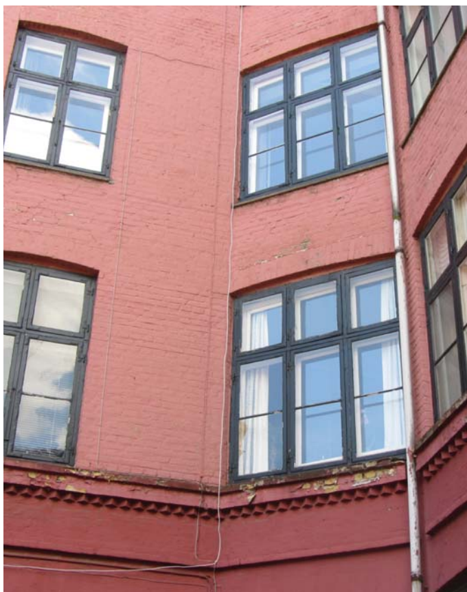
Facadedetalje mod Thorupsgade
