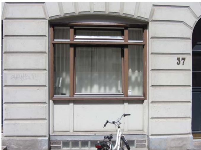
Tidligere butik med uisoleret brystning
