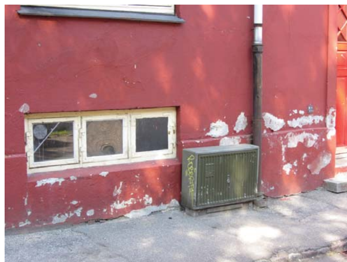
Afskallet sokkelpuds på gadefacade
