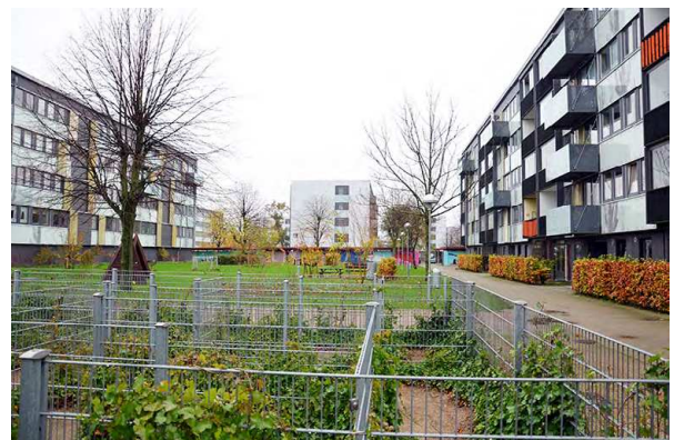
Remisevænget Øst til højre og tilhørende friarealer.
