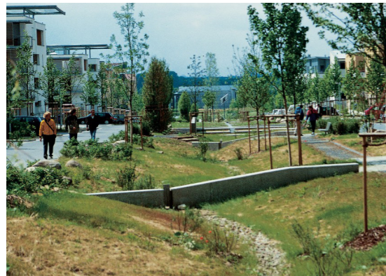
Grønne sideheller, som formår at blødgøre det visuelle miljø og opsamle regnvand ved skybrud.
