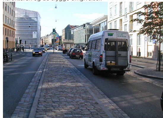
På strækningen fra Nørrebro Runddel til Tagensvej anlægges en midterø, som nedbryder barrierenvirkningen og som skaber bedre forhold for krydsende fodgængere.
