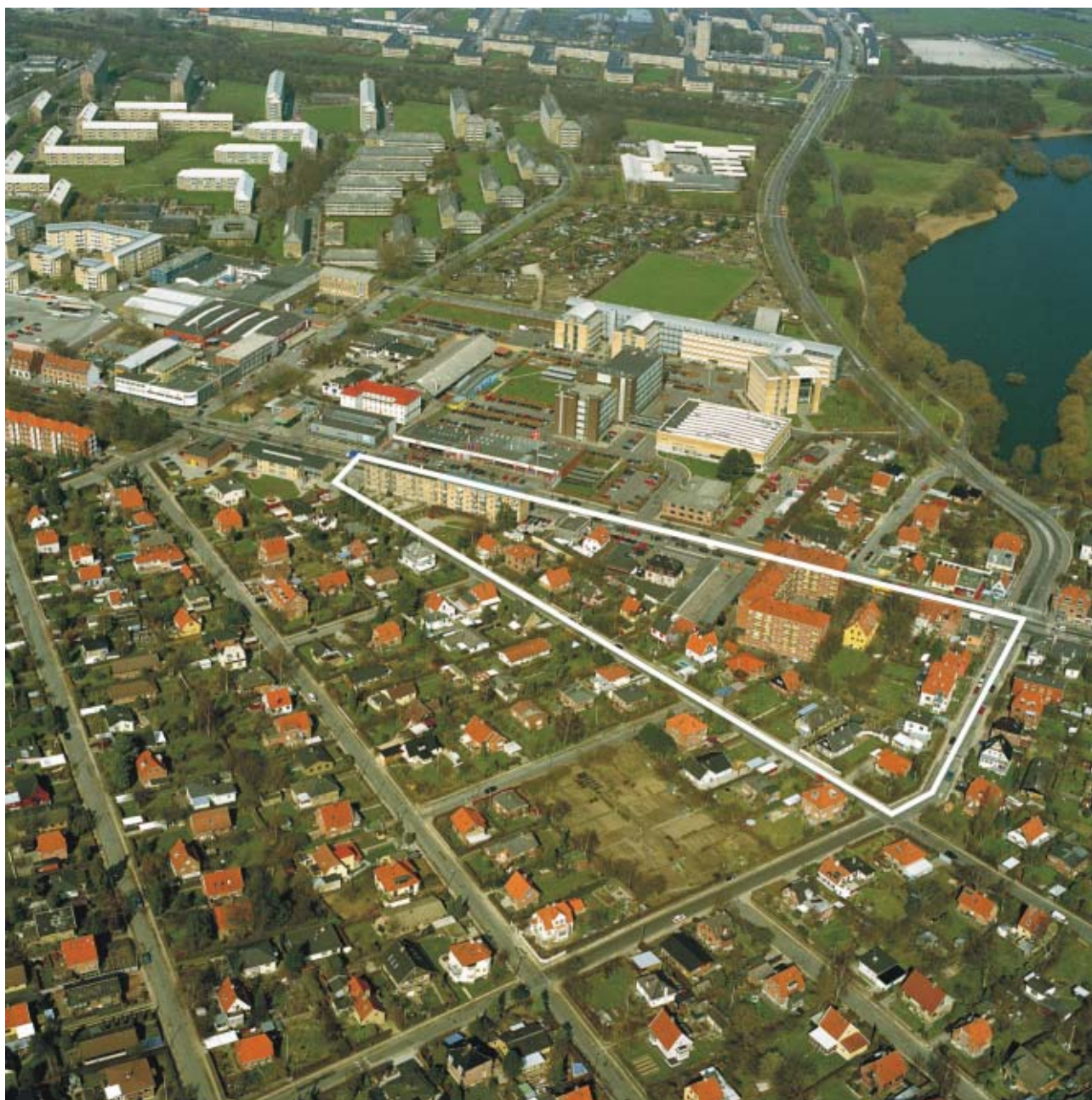
Luftfoto af lokalplanområdet set mod nord. (JW Luftfoto, marts 2004).
