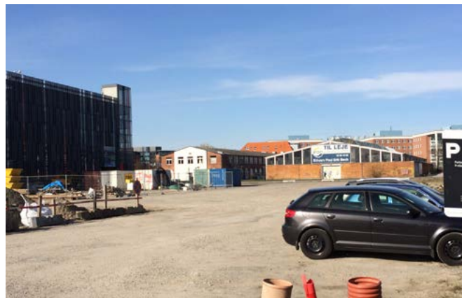
Lokalplanområdet set fra MT-Højgaard's byggegrund fra syd mod nord med p-huset til højre i billedet. P-huset har plads til 659 biler og kan opfylde behovet for parkering i konstruktion i lokalplanområdet samt medvirke til at begrænse parkeringen på terræn. Bagerst i billedet ses 'Hollesten Hallen', der ønskes nedrevet samt 'baghuset' til Teglhølmegade nr. 2 /Scandiagade nr.13.
