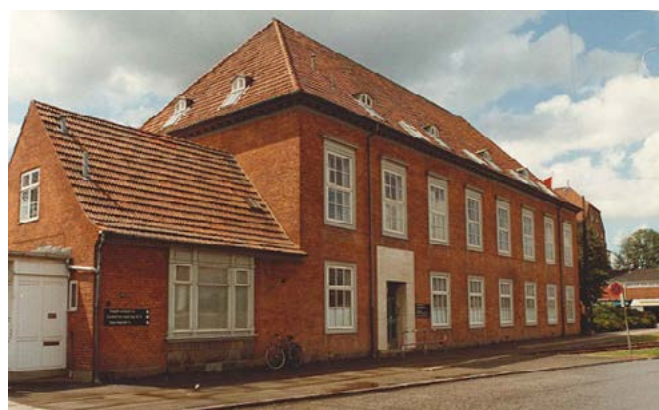
Teglholmegade 2 huser i dag 'Friluftsrådet'. Bygningen er opført i 1925 og fastlægges i lokalplanen som bevaringsværdig.
