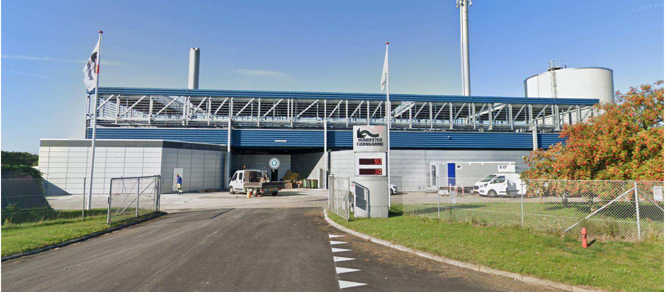
Figur 6.6: Energioptagerne på taget inklusive den bærende stålkonstruktion hos Hundested Varmeværk. Kilde: Google Streetview
