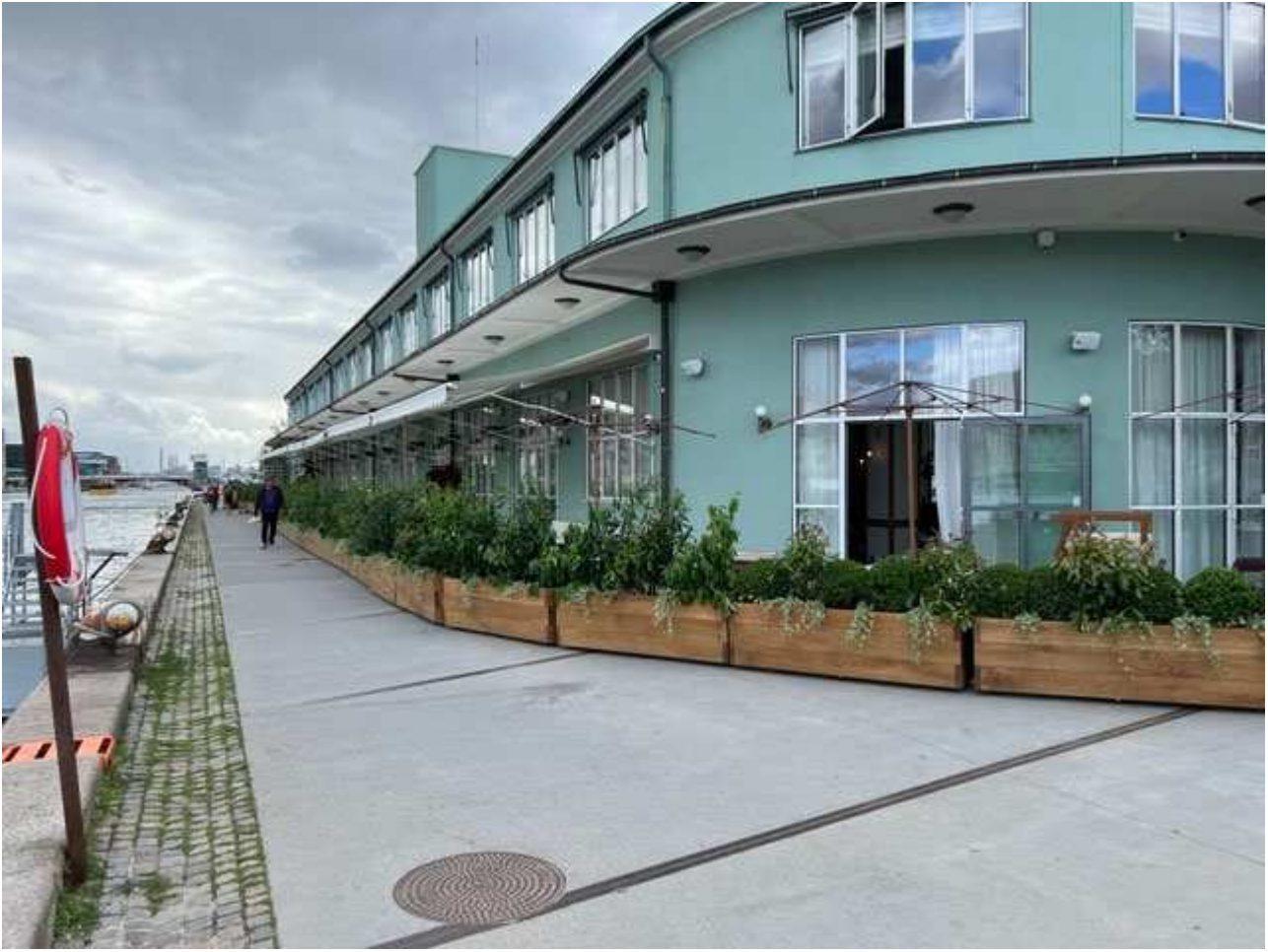
Højtalere og varmelamper
