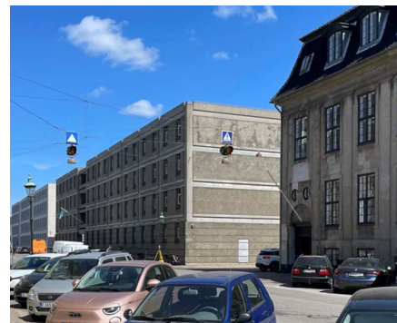
Byggeri af Eva og Niels Koppel med høj bevaringsværdi (SAVE 3), der nedrives. Der fældes 26 træer, der opfylder kriterierne for at kunne udpeges som bevaringsværdige.
