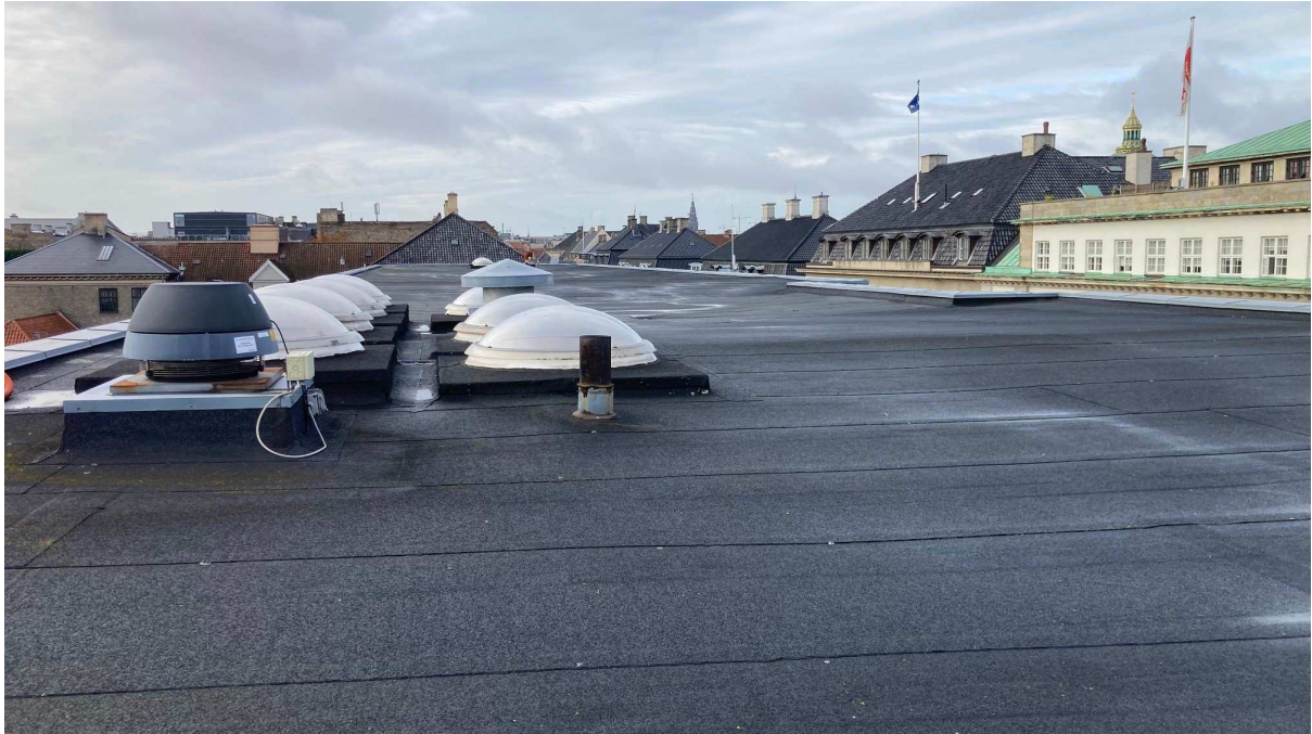
Figur 3 – Tagfladen på den vestlige bygning. Som øvrige tagflader belagt med tagpap uden huller eller sprækker med adgang for flagermus.
