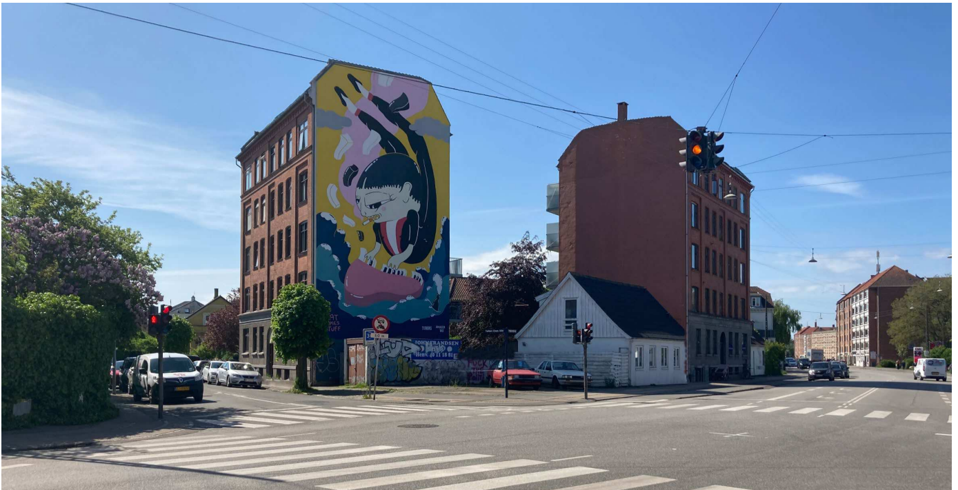
Vejkrydset ved Engelsdsvej 21, hvor Torben Oxes Allé fører ned til Eberts Villaby. Fra denne vinkel ses også det grønne gårdmiljø der allerede er eksisterende i gården bag til Engelsdsvej 21. Foto: Over Byen Arkitekter.
