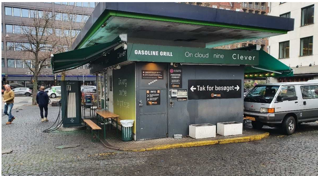
Figur 7. Eksisterende adgang til kælderens i den vestlige ende af Landgreven.
