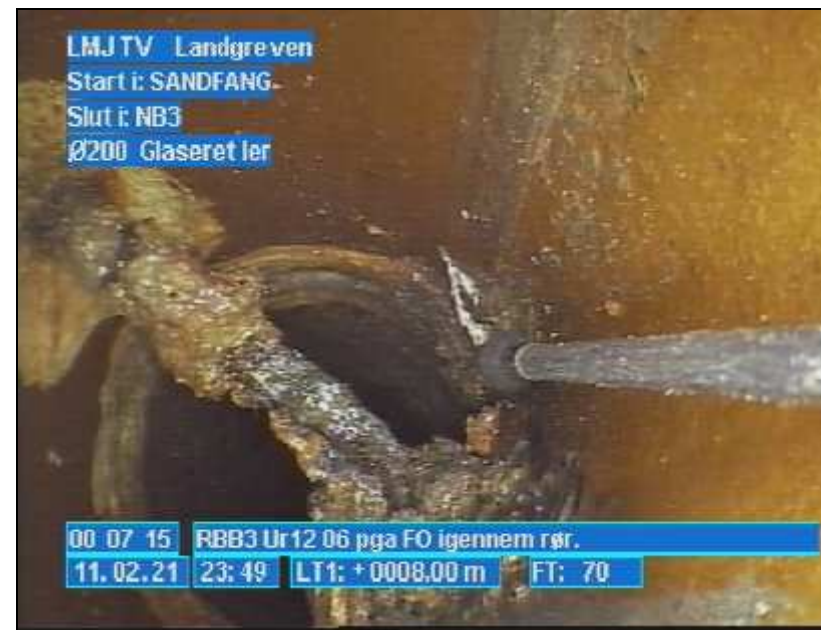
FOTO 070 00:07:13 8.0 m RBB 3 pga FO igennem rør.
