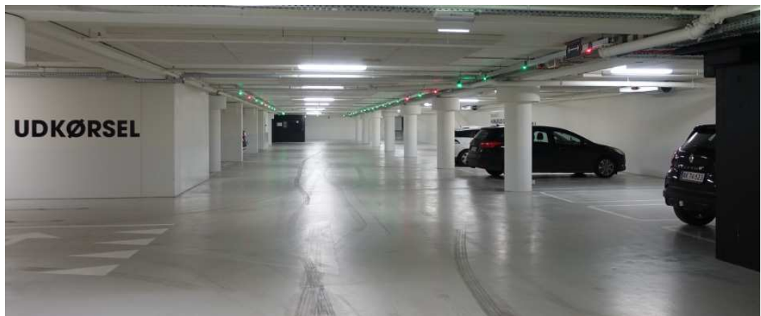
Figur 4. Single Space Detection i et stort parkeringsanlæg i Odense.
