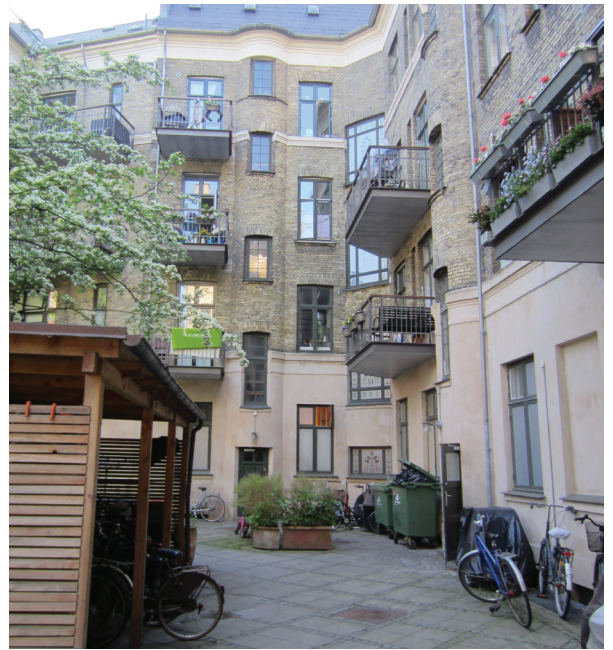
Fundamentsarbejder retableres med permeabel belægning
