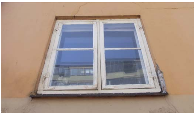
Gammelt vindue med 1 lag glas mod gaden
