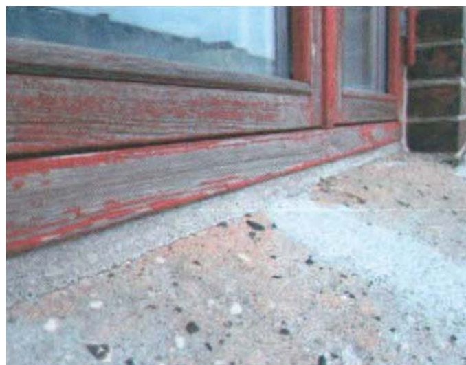
Vindue med sælbænk på gadefacade
