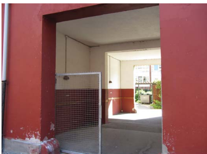
Uisoleret port Højenhald 12
