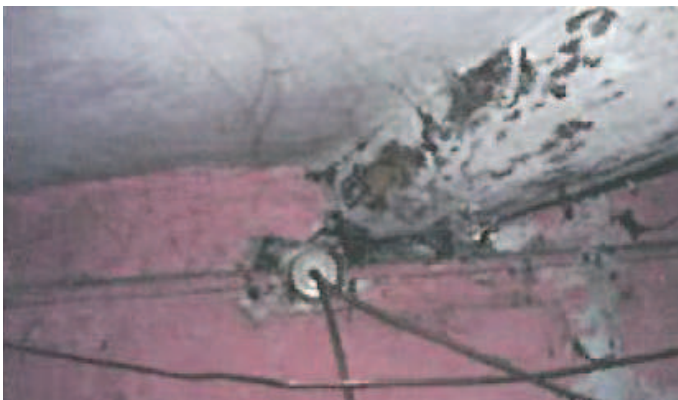
Fugtskadedt kælderbjælke
