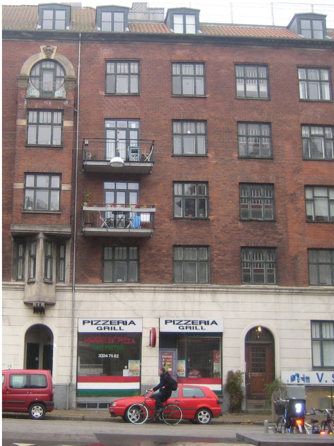
Facade mod Dybbølsgade
