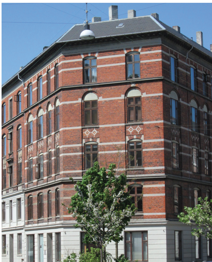
Facade mod Dybbølsgade
