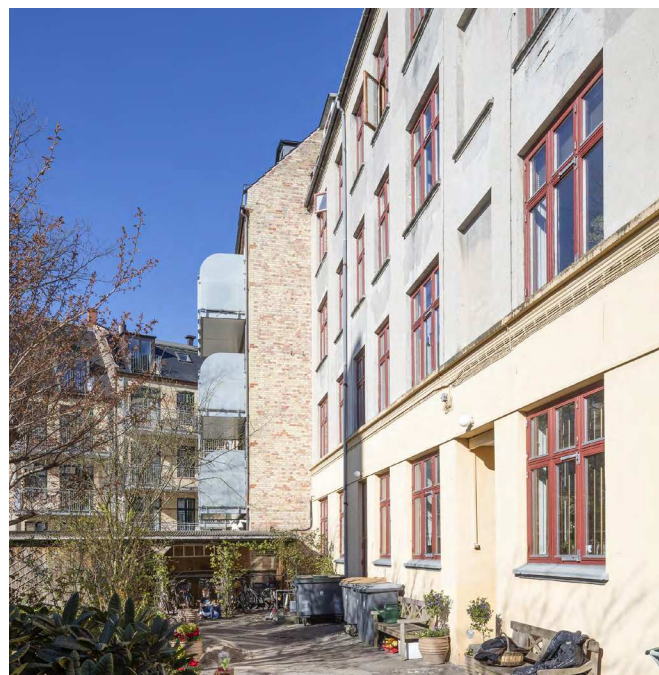
Eksisterende forhold - facade mod gårdsiden. Foto: Torben Eskerod.
