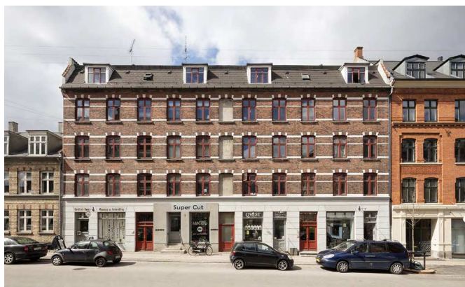
Eksisterende forhold - facade mod Gammel Jernbanevej. Foto: Torben Eskerod.
