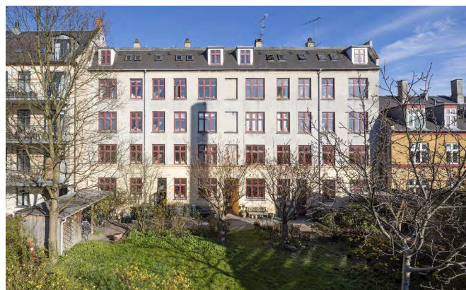
Eksisterende forhold - facade mod gårdsiden. Foto: Torben Eskerod.
