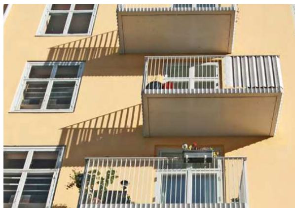
Mikkel Vibes Gade 1 Hvide altaner med enkel raffineret konstruktion der beriger facaden og matcher vinduer.
