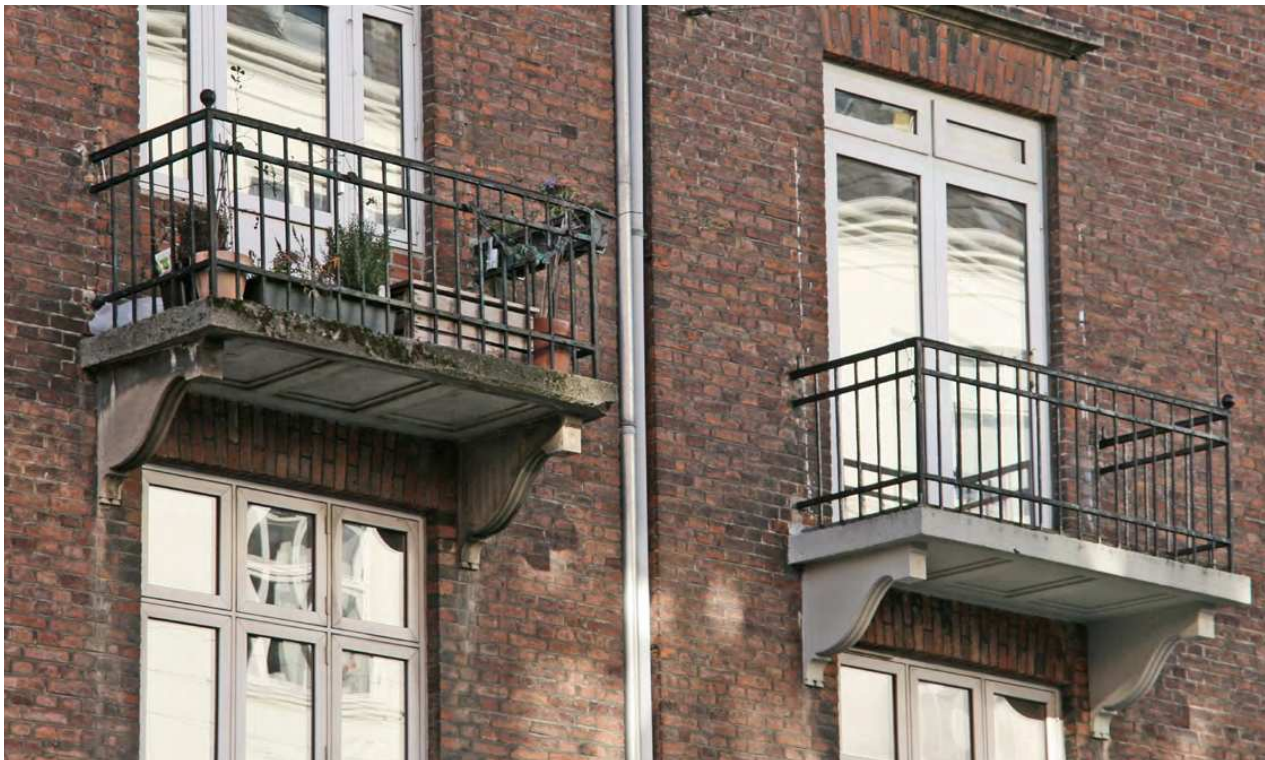
Sommerstedgade Restaureret oprindelig altan.
