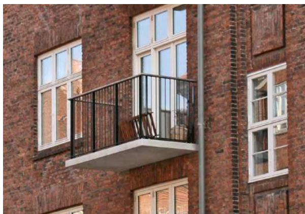
Busstrupgade 7 Den enkle tynde altan bund matcher facadens detaljegrad og stoflighed.
