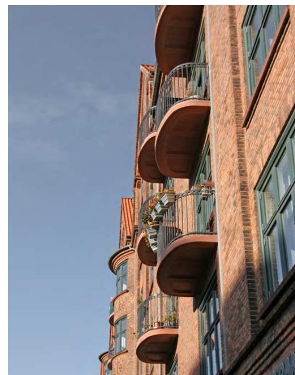
Amager Boulevard 133 De teglfarvede støbte bunde har en detaljering og stoflighed der harmonerer med facaden.
