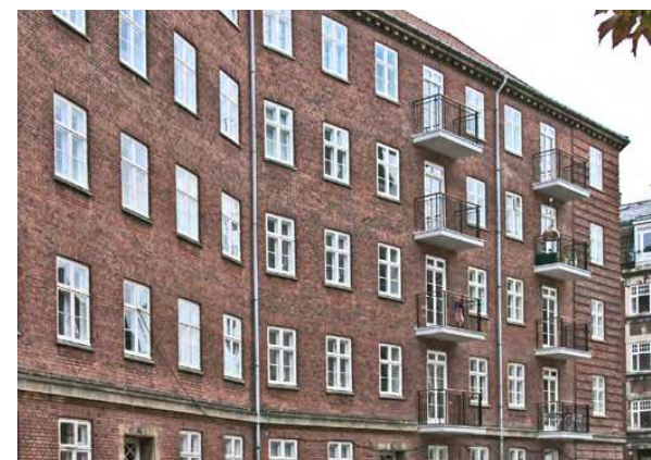
Faksegade 20 De to rækker af altaner passer ind i facaden uden at dominere den.
