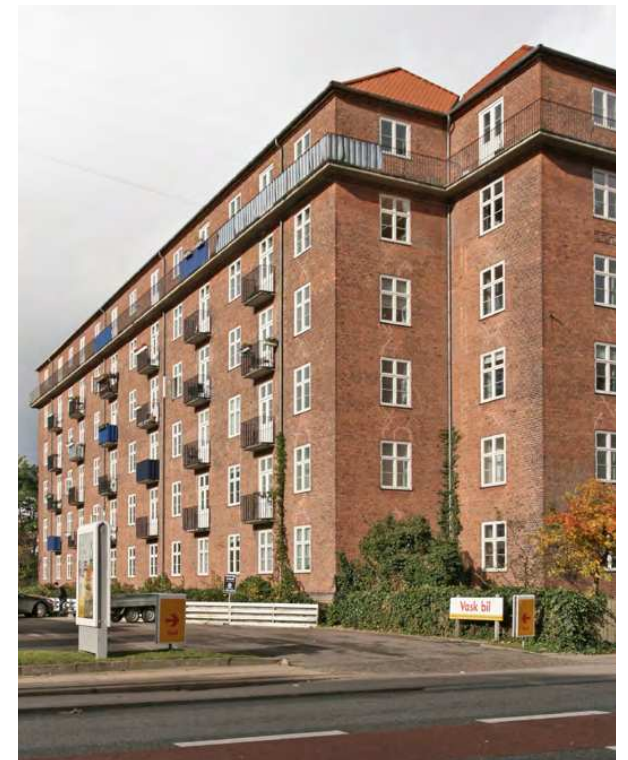
Amager Fælledvej 34 Forskellige altaner på den samme bygning.
