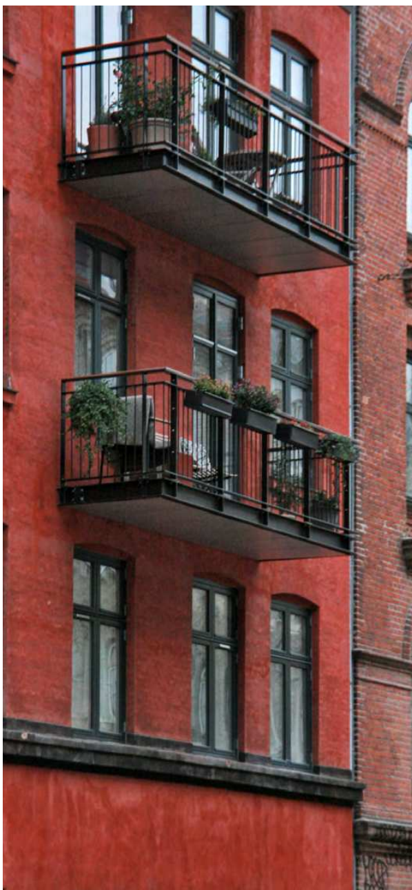
Ravnsborg Tværgade 6 Sorte altaner der matcher farven på vinduer og gesimsbånd. De spinkle værn lader facadens farve og stoflighed skinne igennem.
