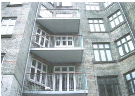
Fotos af eksisterende altaner, der dækker to vinduer med et knæk i facaden imellem vinduerne
