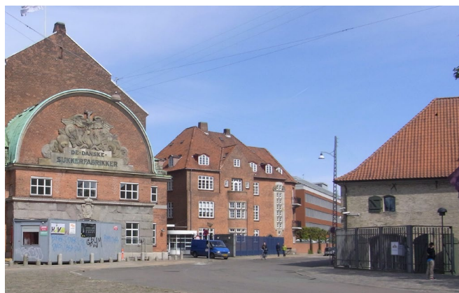
Et af de gamle pakhuse, portnerbygningen og Kalvebod Bastion
